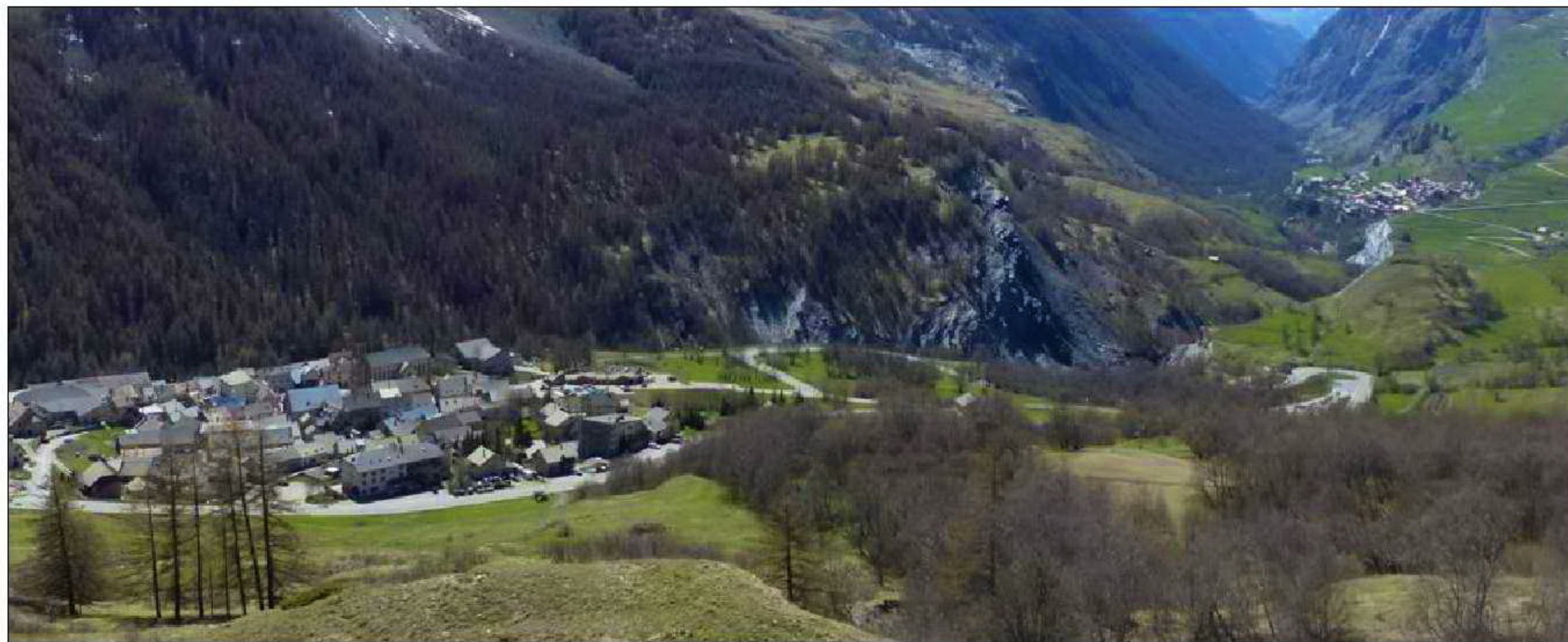
La vallée de la Haute Romanche se trouve enclavée depuis l'effondrement du tunnel du Chambon en avril 2015.
